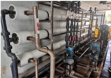
图 3 项目现场：纳滤处理工段 Fig. 3 Project site: nanofiltration treatment stage
